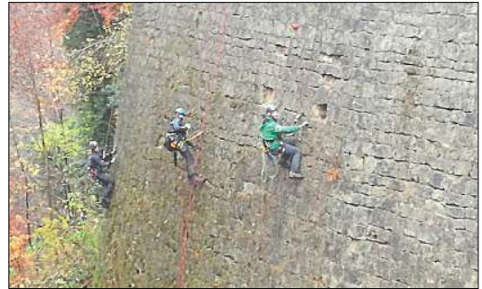
Die „Mauerputzer“ sollen heuer nochmal ran und die Burgmauer vom Bewuchs befreien sowie lose Steine entfernen. Dieses Foto wurde im November 2020 geschossen.
