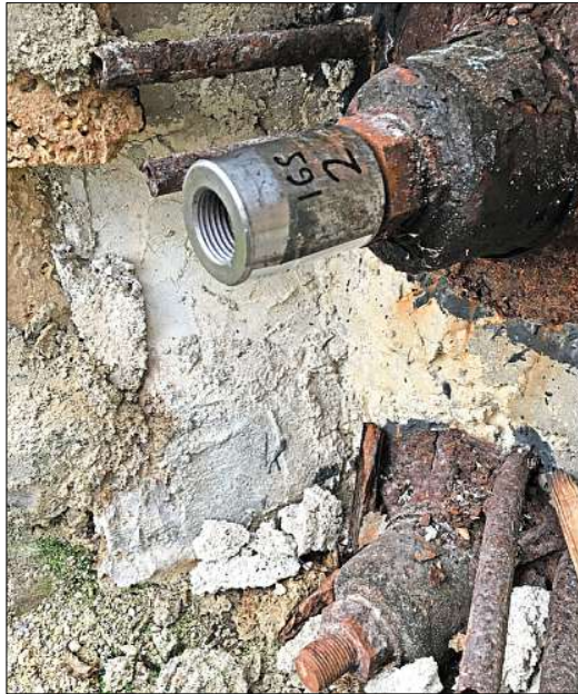
Diese massiven Verankerungen sichern die betonierte Burgmauer.
