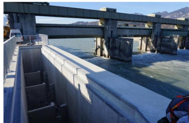
**Abbildung 3-5:** Bestehende Wehranlage mit Teil der Fischaufstiegshilfe im Vordergrund
