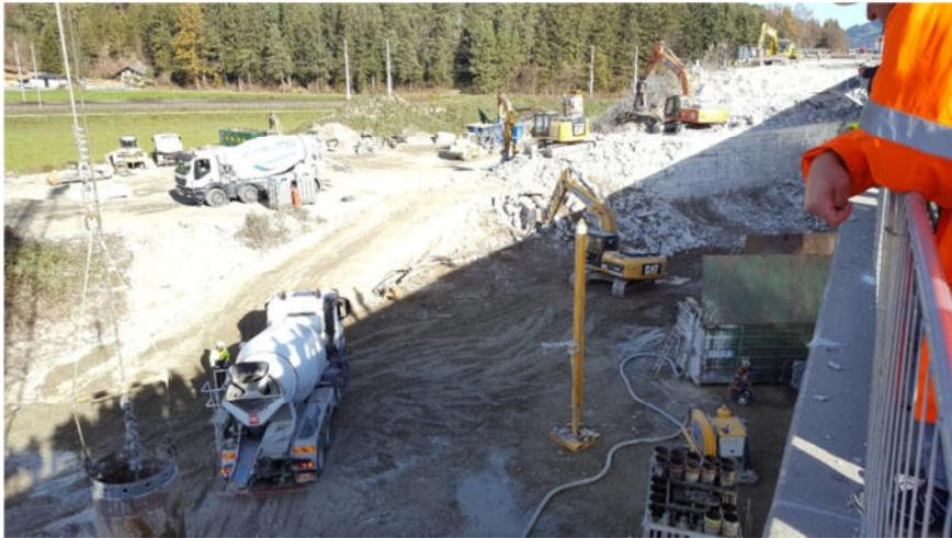
**Abbildung 4-3:** Baufeld mit Abbruch der Widerlager im Hintergrund
