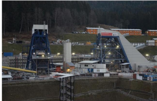
**Abbildung 6-7:** Zugangsschächte mit Lastenaufzügen für den Zwischenangriff Fröschnitzgraben
