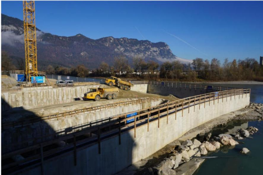
**Abbildung 3-8:** Baugrube für die Erweiterung des Krafthauses und des zusätzlichen Entlastungswehres
