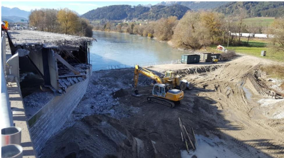
**Abbildung 4-2:** Abbruch der alten Innbrücke, welche als Stahlbeton-Verbundkonstruktion ausgeführt wurde mit halbseitiger Flussschüttung bis zur Mittelsinsel und dem Inn im Hintergrund
