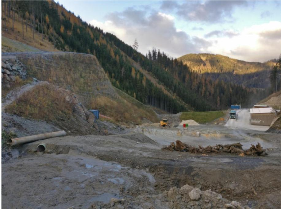
**Abbildung 6-3:** Zufahrt zur oberen Deponie Longsgraben mit Geokunststoffbewehrter-Erde Konstruktion als Böschungssicherung für die Zufahrt
