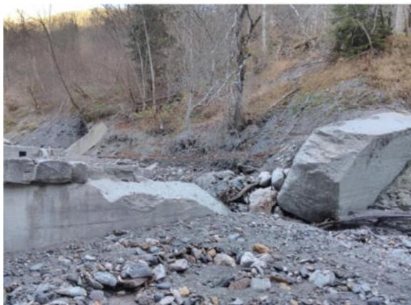
**Abbildung 5-2:** Deutliche Schäden an Wildbachverbauten aus Stahlbeton durch Murengänge
