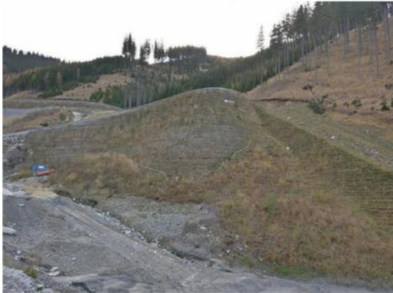
**Abbildung 6-6:** Geokunststoffbewehrte Erde-Konstruktion für eine 25 m hohe Böschung
