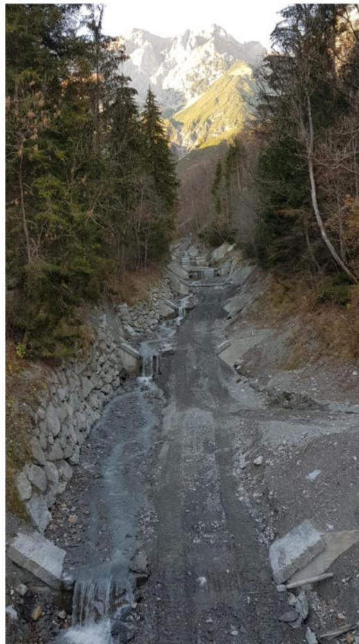
**Abbildung 5-1:** Beschädigte Wildbachsperrren mit aufgeschütteter Baustraße
