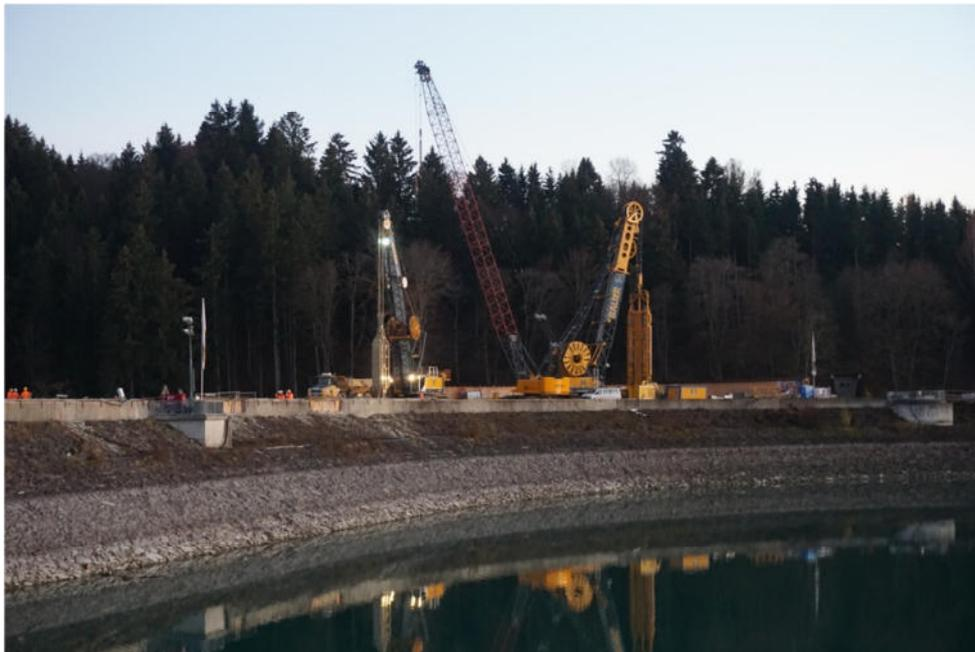
**Abbildung 2-4:** Schlitzwandgreifer auf der Dammkrone während der Herstellung der Schlitzwand
