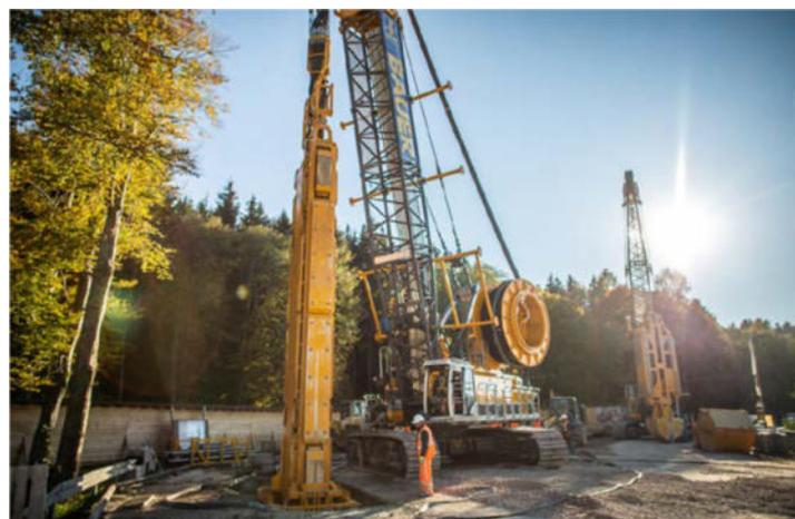
**Abbildung 2-3:** Gleichzeitiger Einsatz von Schlitzwandgreifer und Schlitzwandfräse [3]
