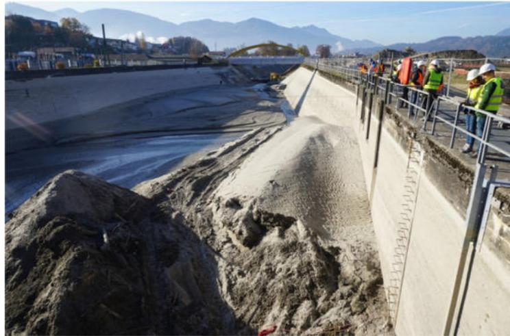
**Abbildung 3-6:** Trockengelegter Oberwasserkanal mit Betonabdichtung mit Zufahrtsbrücke im Vordergrund (links)
