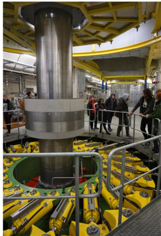
**Abbildung 7-4:** Turbinenwelle mit Stellwerk der Leitschaufeln oberhalb der Turbinenkammer
