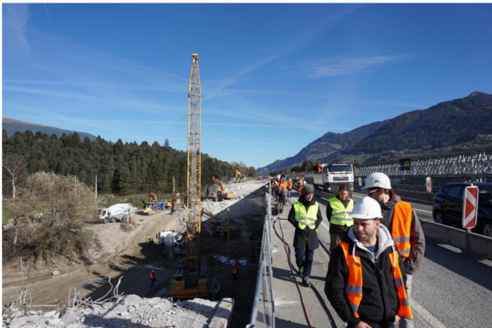
**Abbildung 4-1:** Gründungsarbeiten der neuen Inntalbrücke mit provisorischer Behelfsbrücke als Stahlkonstruktion im rechten Hintergrund
