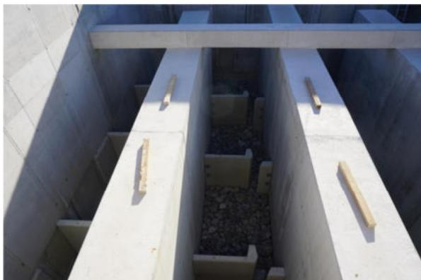
**Abbildung 3-4:** Fischaufstiegshilfe aus Stahlbeton im Bereich des Dotierkraftwerkes
