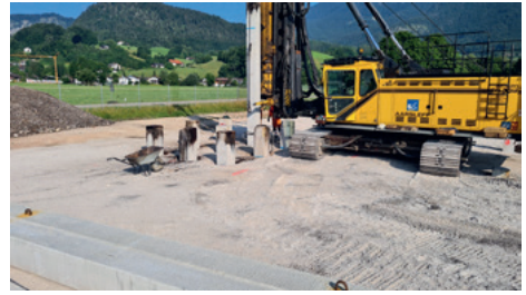
Abbildung 3.2: Einrammen der Pfähle
