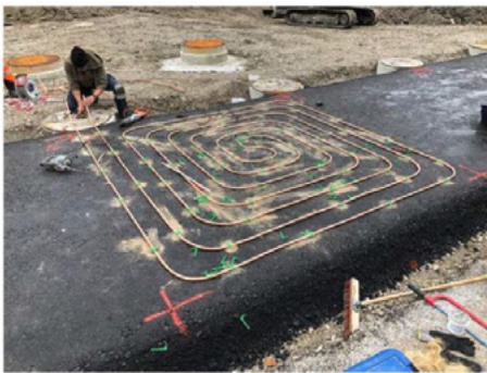
Abbildung 2-9: TECHNIKUM Füssen: Bauausführung, Einbau Kupferrohrregister auf Asphaltragschicht
