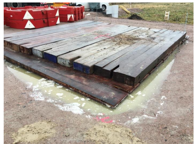
Abbildung 4: Setzung der Kranmatte und ausgepresstes Porenwasser nach Entlastung
