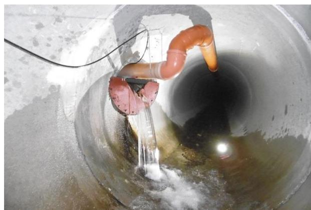
Abbildung 3-1: Drainagewasserfassung am Südportal des Tunnels Rennsteig
