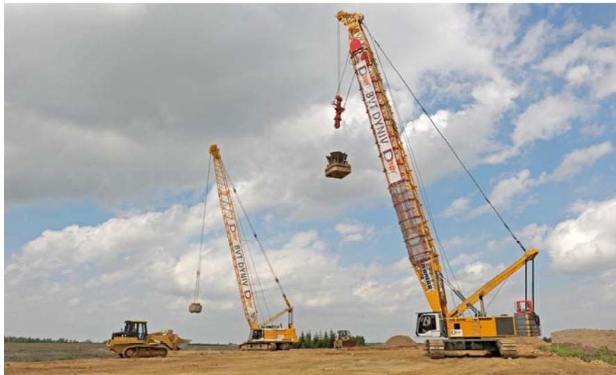
Im Vortrag wird kurz auf die verschiedenen Verfahren der Baugrundverbesserung und die Einordnung von DYNIV<sup>®</sup> bzw. DYNIV<sup>®</sup>-Säulen in die Bereiche Baugrundverbesserung mit und ohne Zugabematerial eingegangen. Anschließend werden die Unterschiede von DYNIV<sup>®</sup> bzw. DYNIV<sup>®</sup>-Säulen erläutert und das Verfahren Free-Fall als Sonderform von DYNIV<sup>®</sup> vorgestellt.
