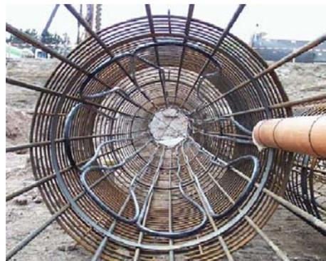
Abb. 3.1.2: Bewehrungskorb für einen Energiepfahl
