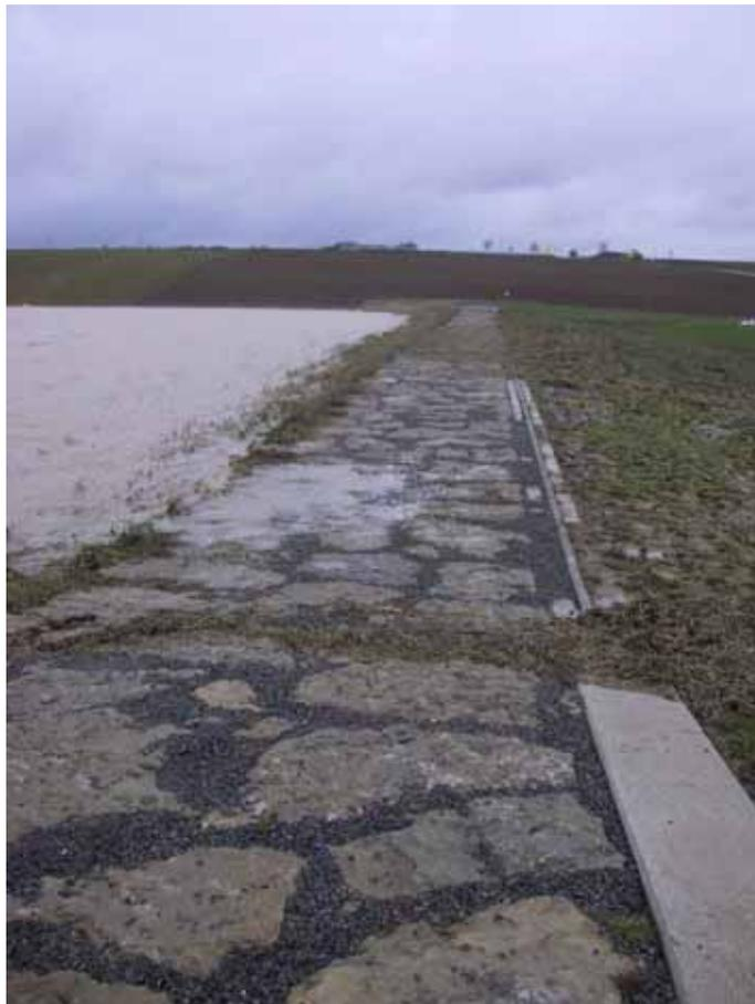
Abb. 6: Blick über die nördliche HWEA bei ablaufendem Hochwasser, erkennbarer Setzungsbereich
