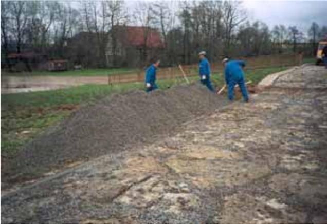
Abb. 13: Angelieferter Magerbeton zur Instandsetzung der Schadensstelle
