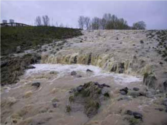
Abb. 10: Schadensstelle während des Zurückgehens der Überströmung
