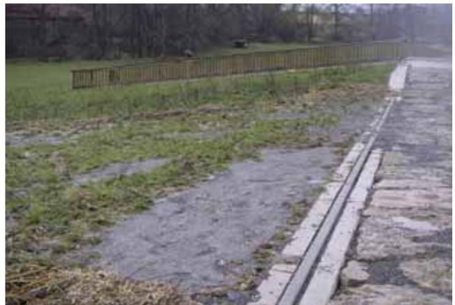
Abb. 16: Durch Überflutung freigelegter Überlaufsporn vor der Justierung
