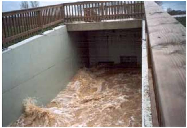
Abb. 4: Blick in das Durchlassbauwerk auf Steuer- und Notschieber (luftseitig)
