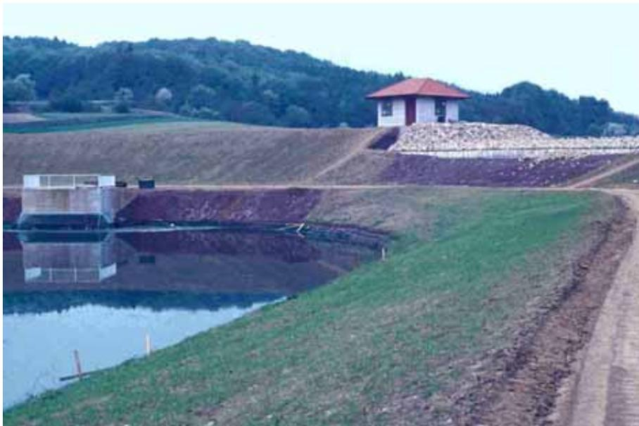
Abb. 5: Hochwasserrückhaltebecken mit Dauerstau und Dammscharte HRB Mühlhausen/Angelbach, Tairnbach (Foto: Bernhart)
