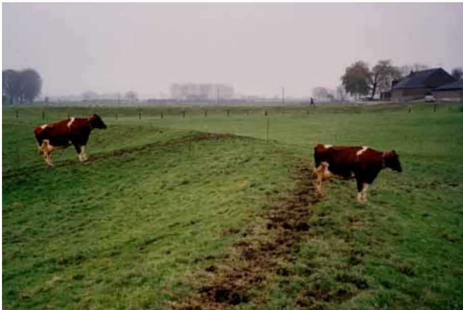
Abb. 10: Schäden an einer Deichböschung infolge Beweidung mit Großvieh (Foto: Bernhart)
