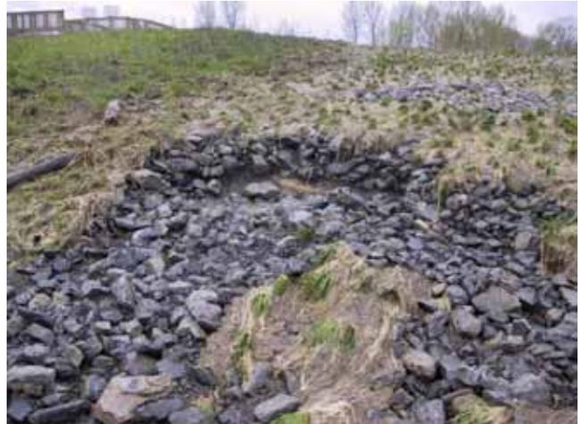
Abb. 11: Schadenstelle unmittelbar nach Überströmung
