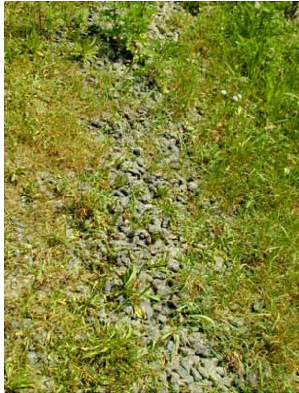
Abb. 2: Begrünung eines Deckwerkes aus Mastix-Schotter durch natürlichen Samenflug
