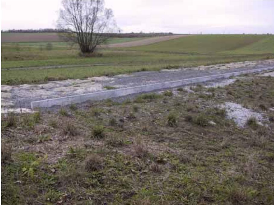
Abb. 17: Justierter Tiefbord des Überlaufspornes nach Fertigstellung
