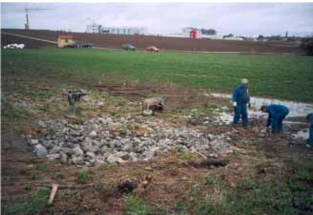
Abb. 15: Schadensstelle im Deckwerk kurz vor Beendigung der Instandsetzung
