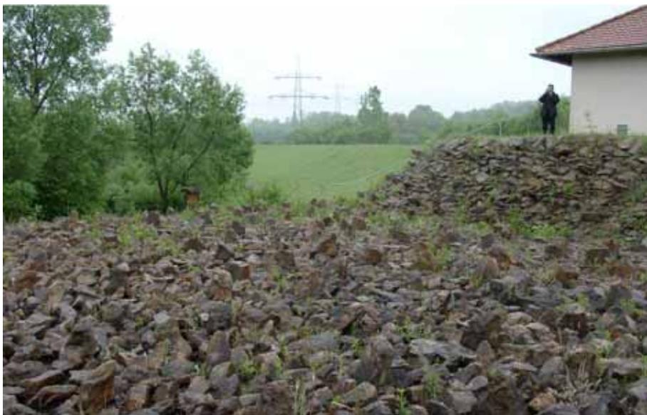
Abb. 7: Kronenbereich einer Dammscharte mit in Beton verlegtem Steinsatz HRB Mühlhausen/Angelbach, Tairnbach (Foto: Bernhart)
