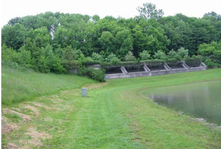
*Abb. 1: Hochwasserentlastungsanlage ausgeführt als Hangseitenentlastung*
