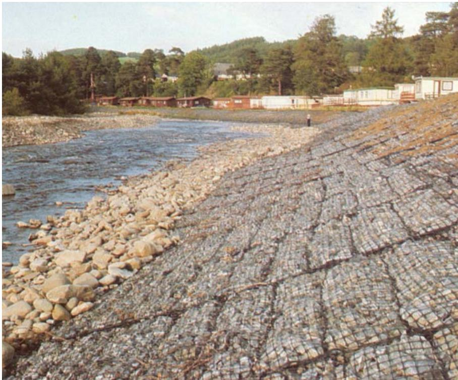
*Abb. 26: Gabionen aus Geogittern als Ufersicherung*
