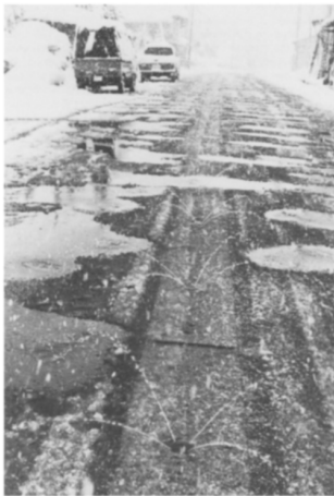
Abbildung 3: Shosetsu (Schneesmelze) Leitung [10]
