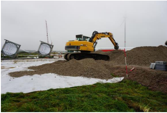
Abbildung 4.3: Aufschütten des Tragschichtmaterials auf der unteren Bewehrungslage (links), und Einbau der oberen Bewehrungslage mit Messstellen für Dehnungsmesstreifen
