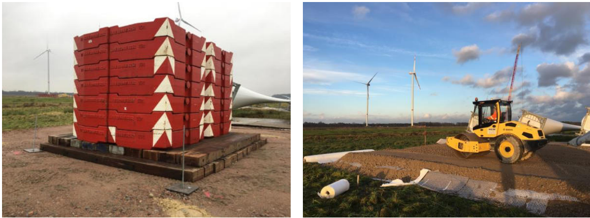
Abbildung 4.2: Kranmatte mit der Maximallast von 280 t (links) und Verdichtung der Arbeitsplattform mit einer Vibrationswalze
