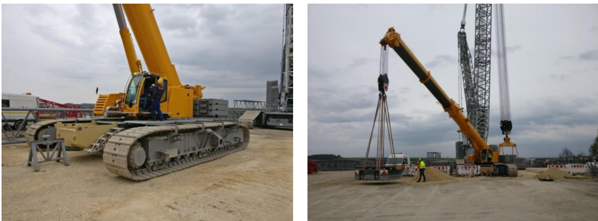
Abbildung 5.11: Teleskopraupenkran Liebherr LTR 1220 auf dem Versuchsfeld (links) und während der Durchführung von Lastfall LF 3 (rechts)
