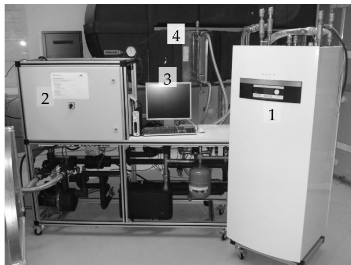
Abb. 4.12: Prüfstand Geothermie in einem Betriebstechnikraum der Haltestelle Europaplatz mit Wärmepumpe (1), Steuerungseinheit (2) und Messrechner (3). Im Hintergrund Wärmeaustauscher (4) im Belüftungskanal der Haltestelle.
