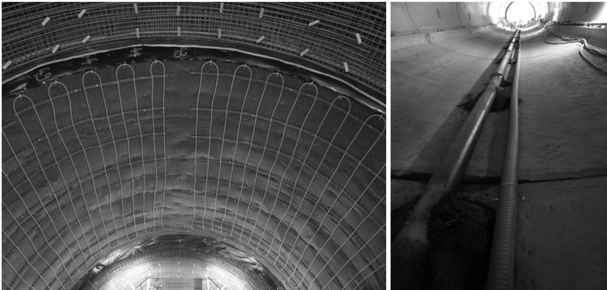
Abb. 4.8: Links: Absorbersystem vor Einbau der Innenschalbewehrung im Fasanenhof-tunnel. Rechts: Hauptleitung (rechte Leitung im Bild) zwischen Energieblöcken und Betriebstechnikraum in der Tunnelsohle verlegt.
