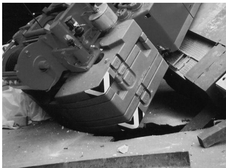
Bild 7.16 In Hohlraum eingebrochenes Stützbein
