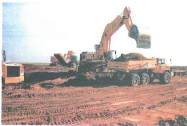
Erdbaubetrieb auf dem Flughafen Leipzig:
