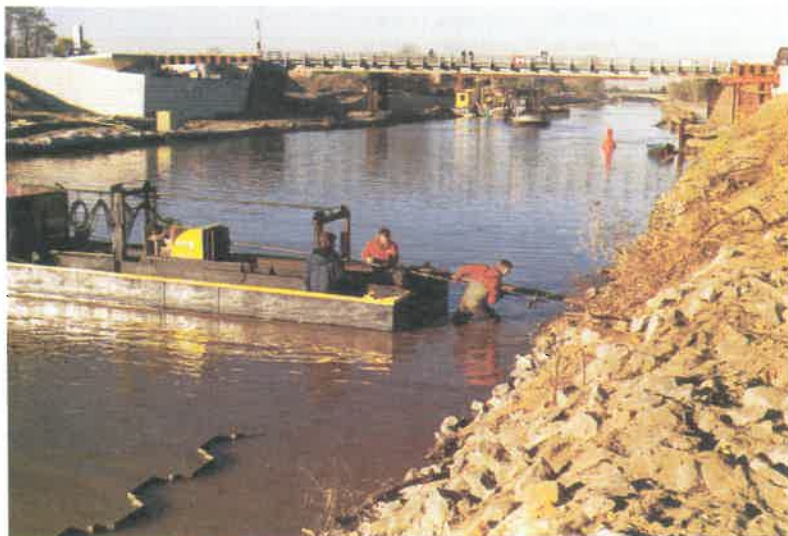
A8.1: Einbringen von Schraubankern am Mittellandkanal in Hannover
