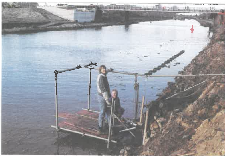
A8.3: Herstellen eines Widerlagers am Mittellandkanal in Hannover
