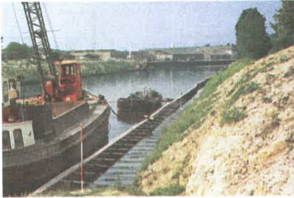
Bild 2.2.2: Foto einer Spundwand mit Schraubankern
