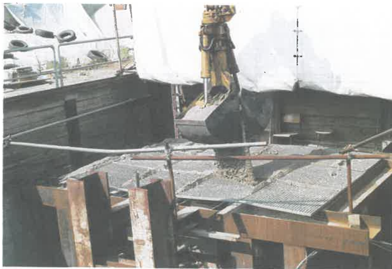
Bild 5.1.7: Einbau des Sandes in lockerer Lagerung (Foto)
