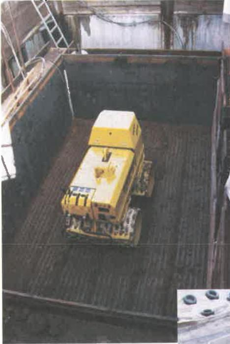
**Bild F 3:** Materialeinbau mit der Grabenwalze
