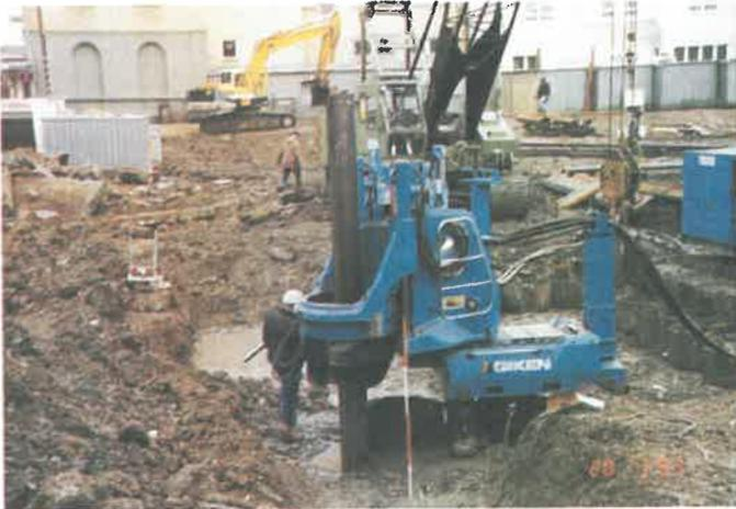
Abb. 4: Einpressen der Spundwände mit dem Z-Piler
