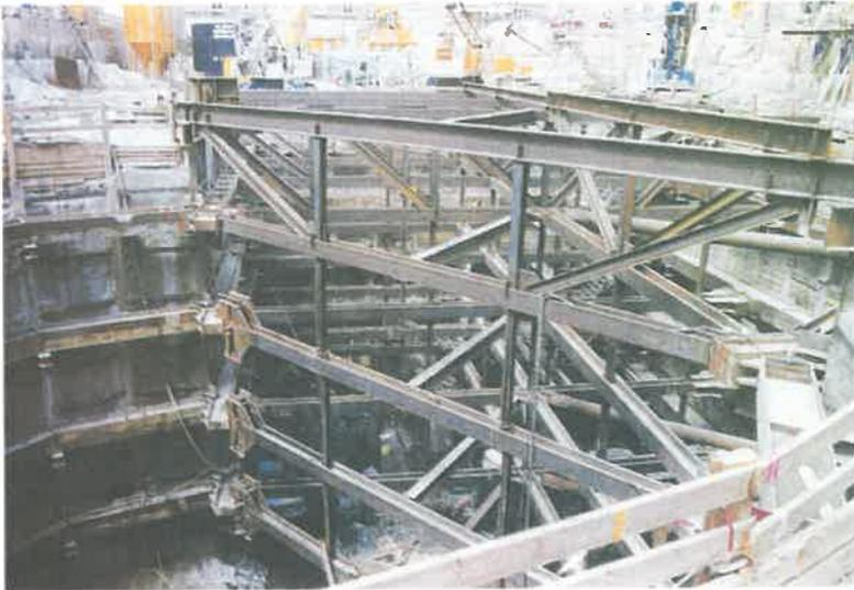
Bild 13: Blick in den Rechteckteil des ausgesteiften Startschachtes mit der vorgespannte Steife ST 4 im Vordergrund, Aushubniveau bei -18 m unter GOK im Mai 1997
