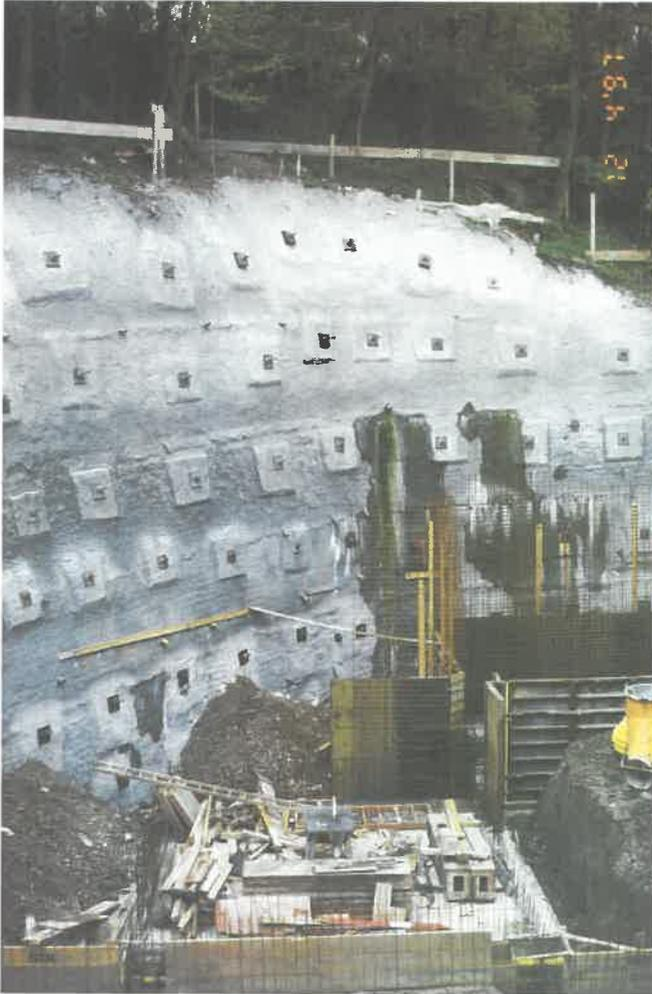
**BILD 6: Schichtwasserzutritt in Gipskeuperauffüllung
