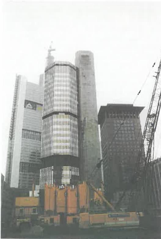
**Bild 1:** Pfahlbohrarbeiten auf der Baustelle MAIN TOWER mit angrenzender Hochhausbebauung (von links: Commerzbank-Hochhaus, Hochhaus der Landesbank Hessen-Thüringen und Japan-Center)
