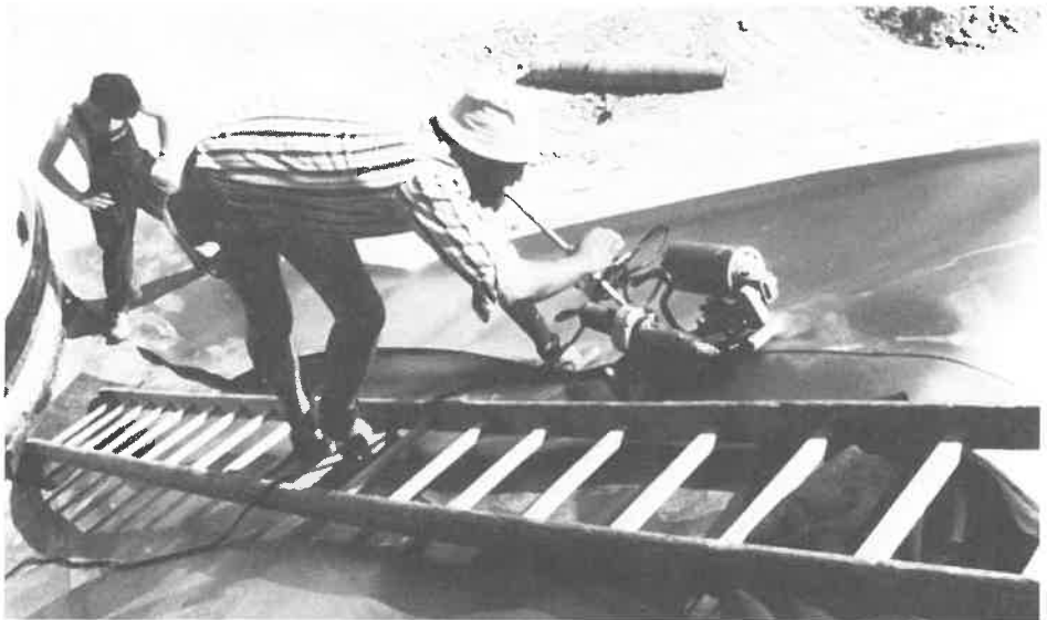
Schweißarbeiten an einer KDB von der Leiter aus
