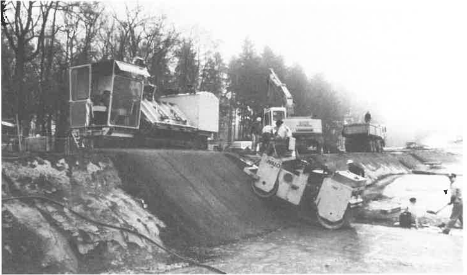
Herstellen der Asphalttragschicht an einer kurzen, steilen Böschung
