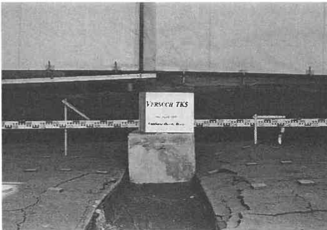
Bild A 84: Oberflächenverformung infolge Bruchkörperausbildung
