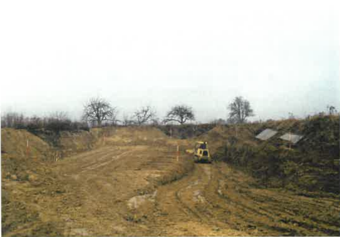
Bild A 75: Aushub und Herstellen des Schüttplanums
