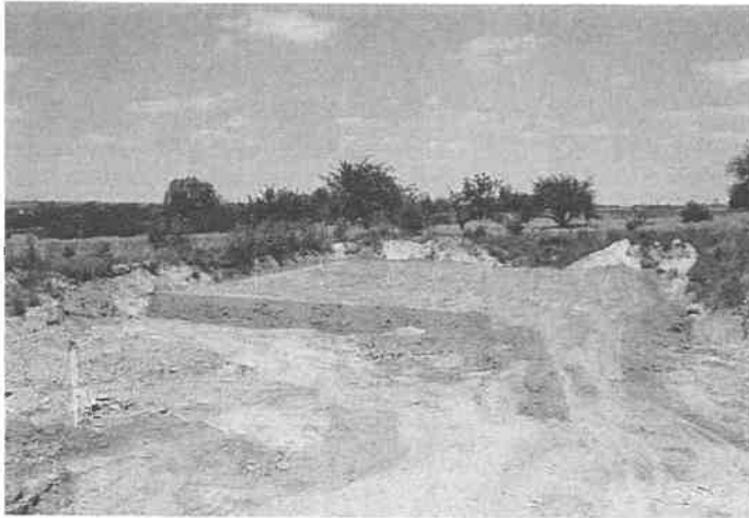
Bild A 78: Fertiggestellte Schüttung
