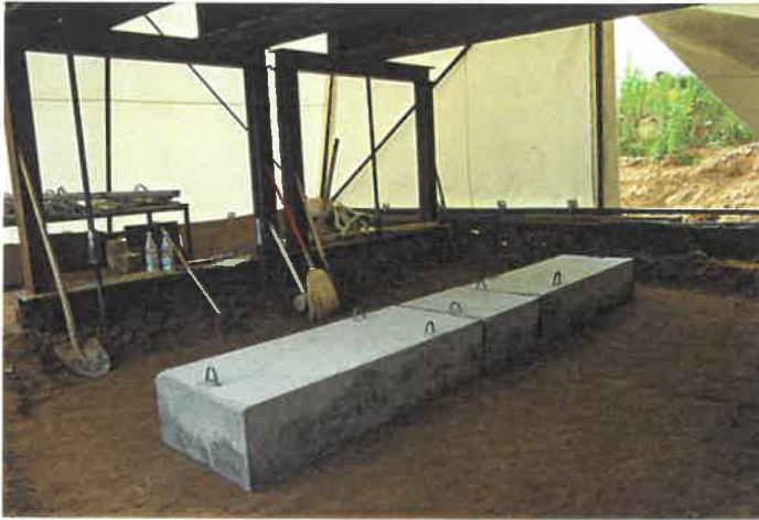
Bild A 81: Anordnung der Fundamenteile
