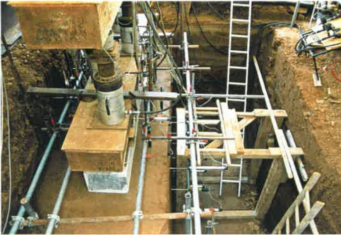
Bild A 80: Versuchseinrichtung Böschungsversuche
