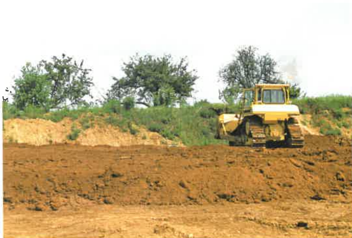
Bild A 76: Locker eingebaute Schüttlage aus Lößlehm
