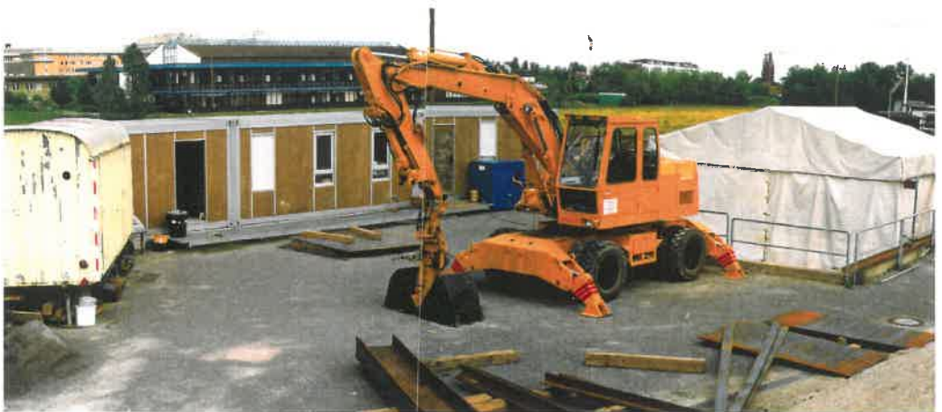
Freigelände des Instituts für Geotechnik
