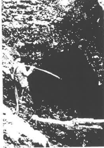
Abb.2-4: Vermischen des Bodens mit Zementsuspension (KRAUTER 1992)
