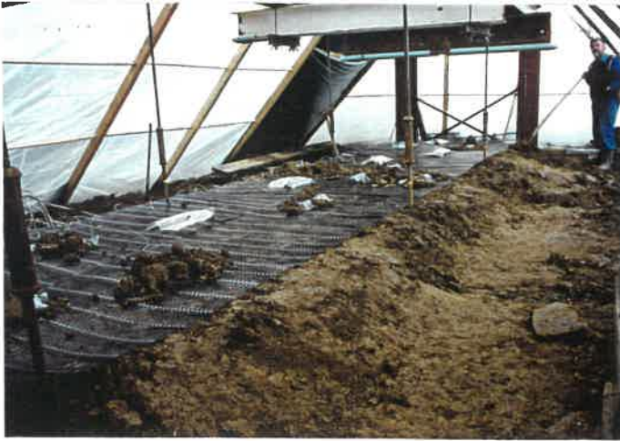
Bild 120: Versuchsfeld mit Geogitter (TENSAR)
