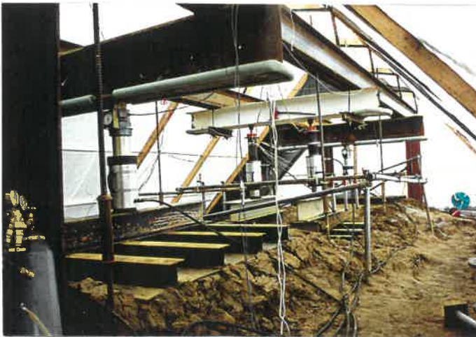
Bild 123: Rand- und Mittelfeld nach Versuch (verformt)
