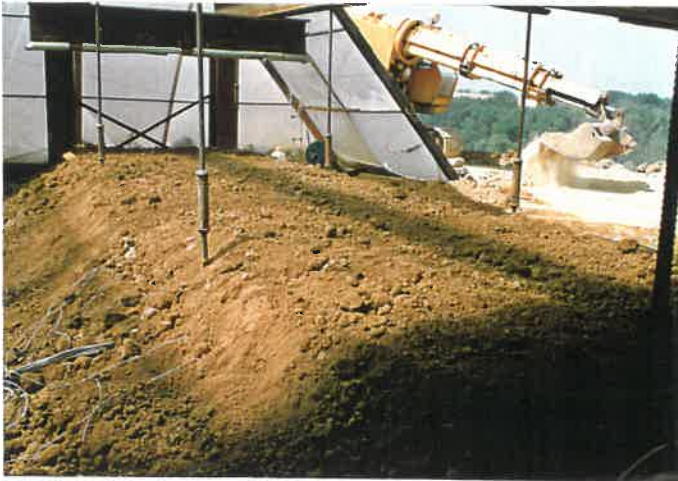
Bild 121: Boden über Geotextil aufgefüllt und geglättet
