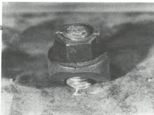
Abb.3.1-2 Schneidenförmiger Anschluß des Ankers
