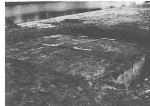
Abb.2.1-10 Aufwölbung des Verankerungsbodens, vorderer Fluchtstab über dem Anker liegend
