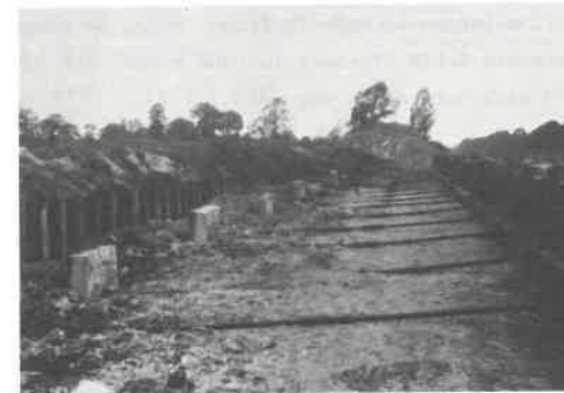
Abb. 2.1-1 Bauzustand Umschlagstelle Fresenburg mit eingebauten Versuchsankern und -platten
