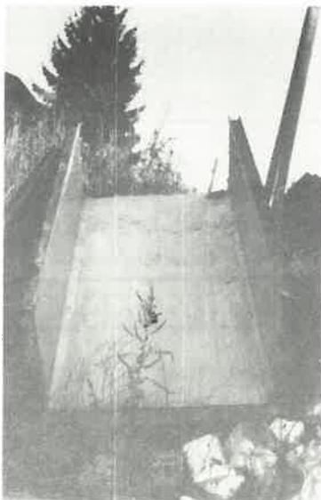
Bild 3.4 Schablone zur Schlitzherstellung
