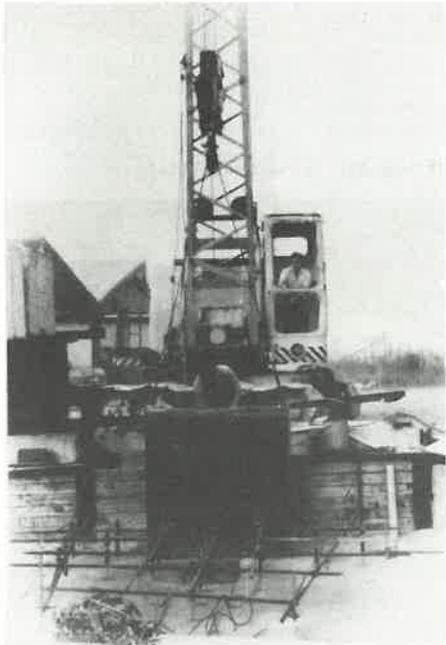
Bild 3.15 Herausziehen der Schlitzschablone
