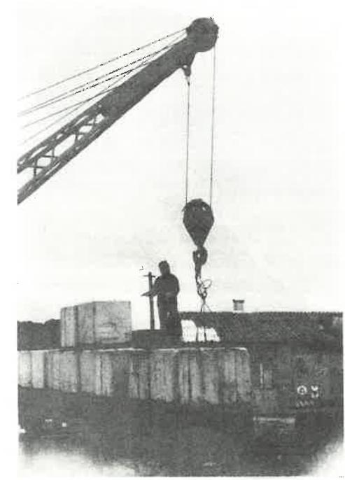
Bild 3.18 Umsetzen der Ballastwürfel
