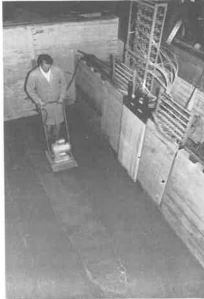
Bild 8: Dichte Lagerung des Sandes
