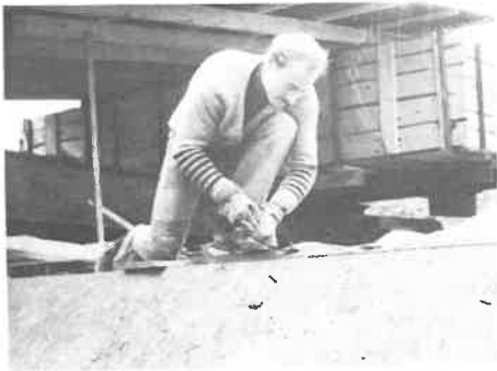
Bild 3.20: Feinplanieren der Böschung
