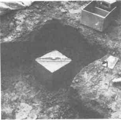
Bild 5.1: Herstellen des Bodenquaders
