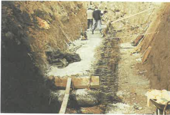
Bild 8. Steilwand-sicherung, System IGB Stuttgart, im Bau
