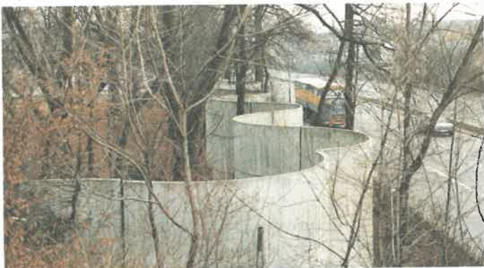
Bild 4. Lärmschutzwand zwischen Schloßpark und B 14 in Stuttgart-Mitte
