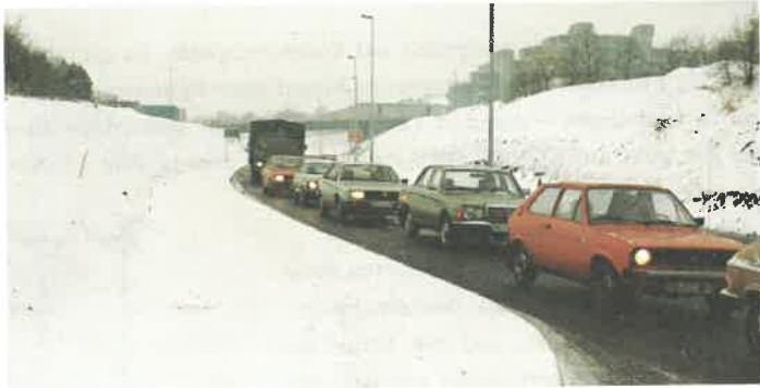
Bild 15. Lärmschutzwand in Böblingen
