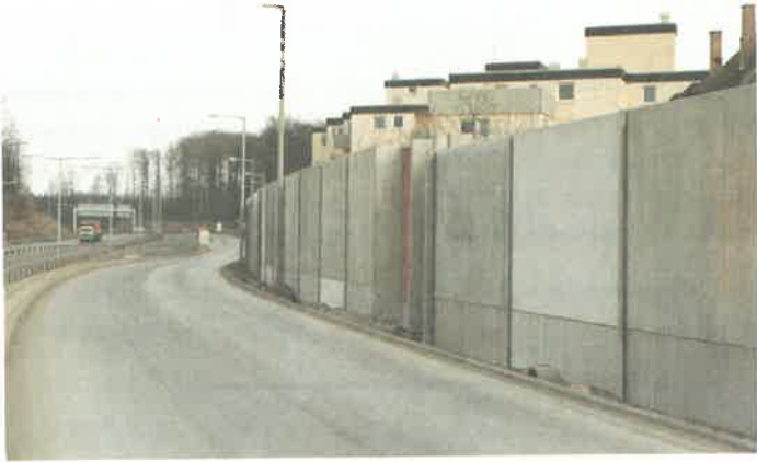
Bild 3. Lärmschutzwand in Stuttgart-Vaihingen, B 14.
