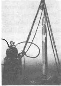
Bild 1 Seitendruckapparat (Gummiblase) nach KÖGLER, 1933
