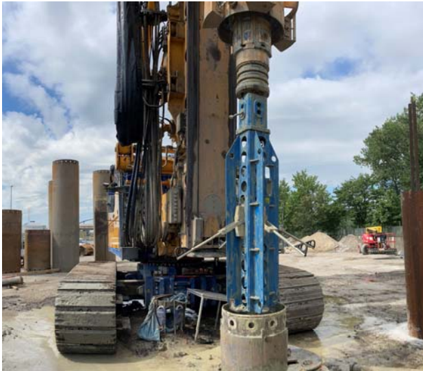
Abb.: Überprüfung der hergestellten Fußaufweitung mittels Pfahlinspektor
