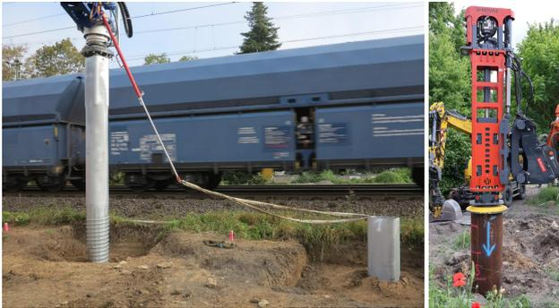
Tiefgründungen mit Schraubfundamenten und Rammrohren
