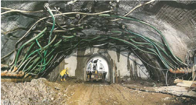
Abb.: Vortrieb am Rauhebergtunnel (Foto: Deutsche Ausschuss für Unterirdisches Bauen e. V.)
