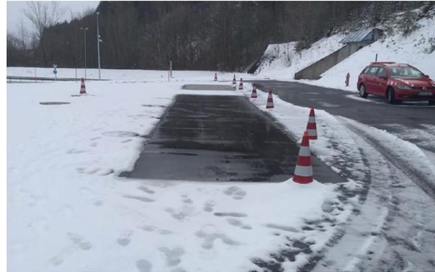
Abb.2: Durchströmte Freiflächenheizungen bei Schneefall
