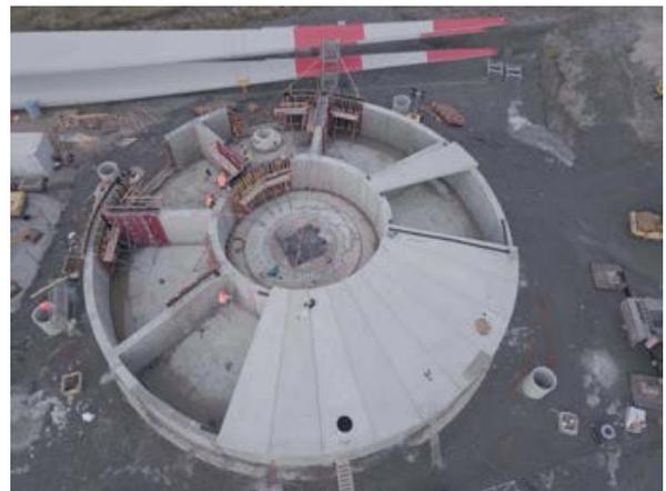
In dem Vortrag wird über die Errichtung einer Windenergieanlage (WEA) auf der Deponie Nord-West in München berichtet. Im Vordergrund stehen dabei die geotechnischen Aspekte und die besonderen Gründungsverhältnisse auf der Deponie, die zur Entwicklung eines Sonderfundaments geführt haben.
