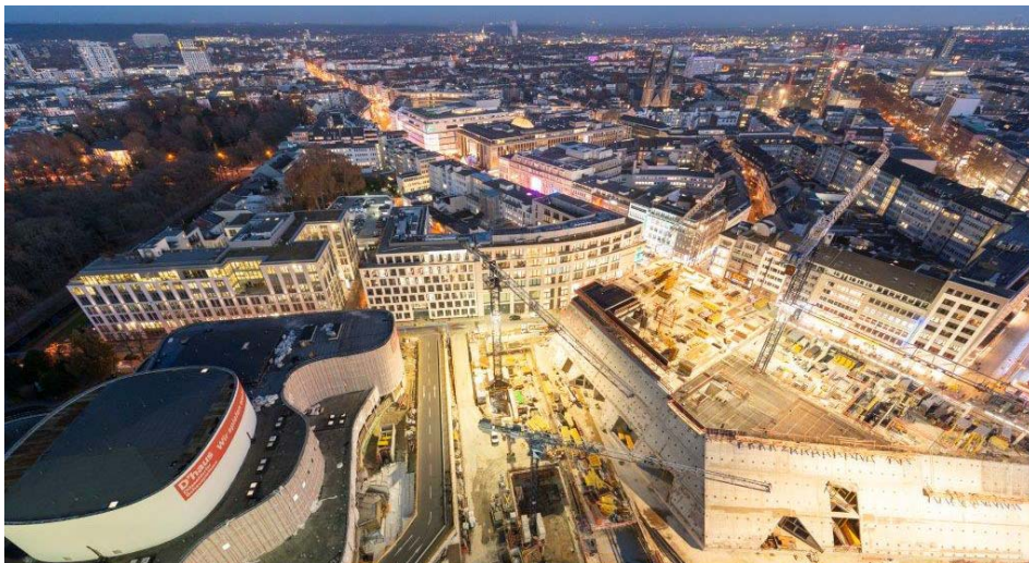
Großprojekt Kö-Boden II, Düsseldorf: Baustelle
