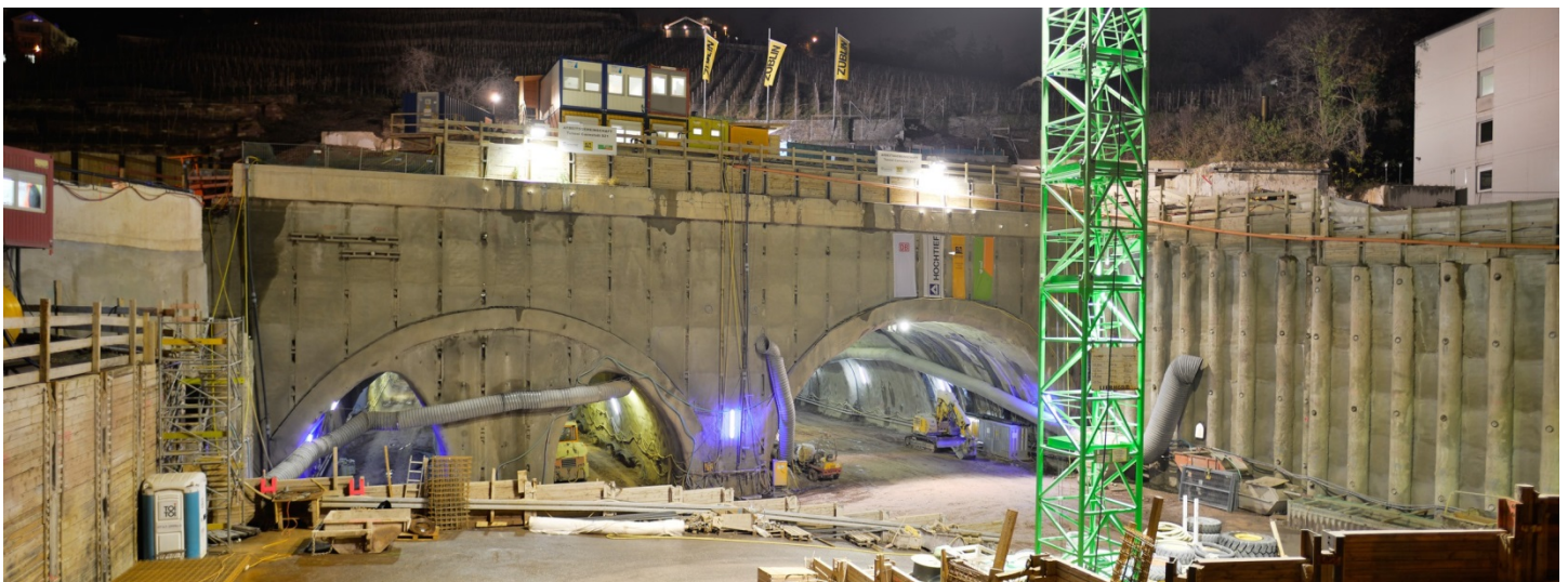
Verzweigungsbauwerk von Feuerbacher und Cannstatter Tunnel. Foto: Arnim Kilgus (Quelle: http://www.bahnprojekt-stuttgart-ulm.de/ )
